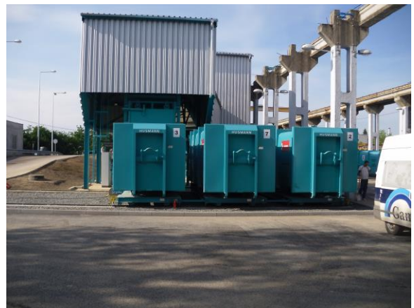
Bild 2 und 3: Gesamtansicht der Umladestation mit Verschiebewagen und Pressbehälter
