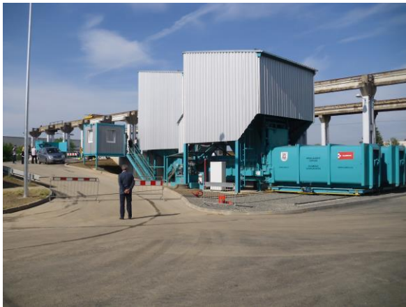
Bild 2 und 3: Gesamtansicht der Umladestation mit Verschiebewagen und Pressbehälter
